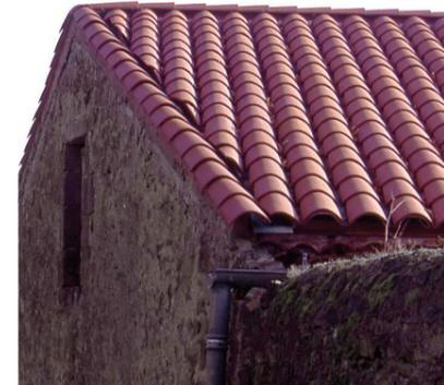
Pose de tuiles de récupération sur forme ondulée (il existe plusieurs procédés). On peut poser une ou deux couches de tuiles (obligation de deux couches sur ce site).
