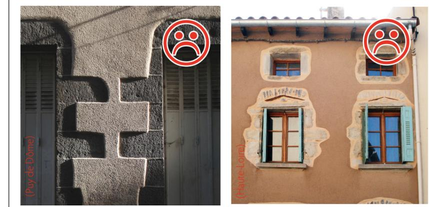
Exemples d'enduits réalisés de manière erronée : on ne doit pas non plus grossièrement détourner les pierres de grande taille, elles aussi destinées à être recouvertes
