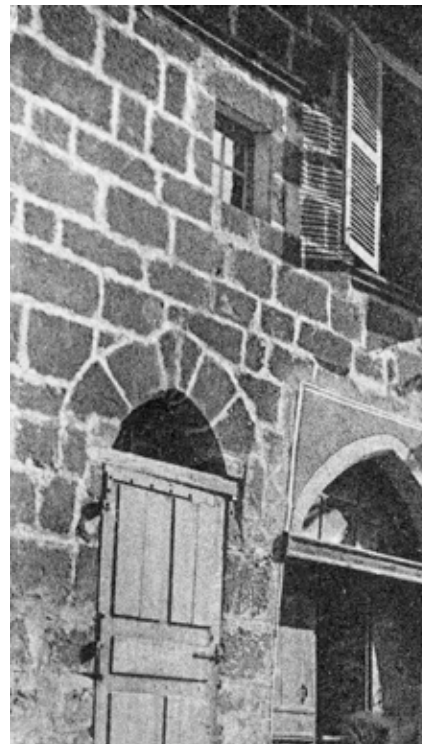
Façades d'origine médiévale en pierre appareillée (au début du XXe siècle, en 2008). On constate pour celle de gauche l'effacement des joints, qui se sont un peu érodés. Les lits présentent des largeurs différentes mais toujours régulières.
