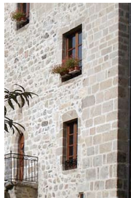
Une pratique moderne : le décrépiage, suivi de rejointoiement. Ici, la technique peut se justifier par la volonté "archéologique" de conserver un aspect ancien, de même que par la présence de parties en pierre appareillée.
