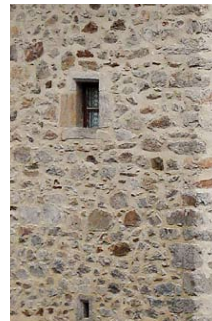
Une pratique moderne : le décrépiage, suivi de rejointoiement. Ici, la technique peut se justifier par la volonté "archéologique" de conserver un aspect ancien, de même que par la présence de parties en pierre appareillée.
