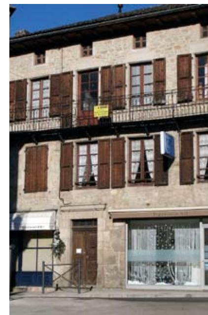
Décapage d'un bel immeuble néoclassique (postérieur à 1828) qui a effacé ses dispositions architecturales d'origine.
