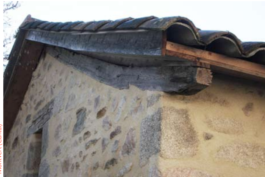
Pose de tuiles anciennes sur forme ondulée (on distingue la forme plus claire sous la tuile): l'illusion est presque totale. Il existe plusieurs toitures de ce type à Laroquebrou, peu facile à détecter.
