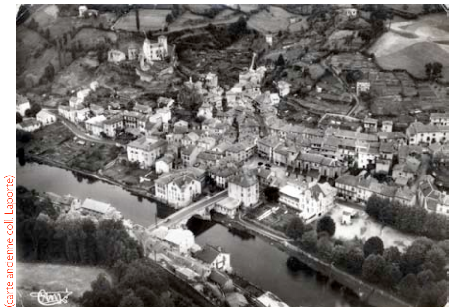
Vue aérienne des années 1950, qui montre bien l'articulation des diverses parties historiques du site.
