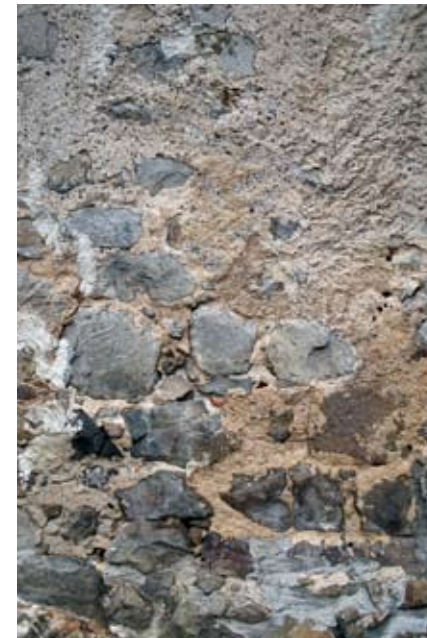
Maçonnerie ancienne érodée, dont l'enduit révèle les moellons. Noter le sable avec particules noires d'origine volcanique.
