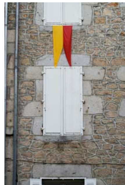
La pire des solutions, du point de vue technique comme du point de vue visuel, le rejointoiement au ciment. On risque ainsi d'entraîner des dégradations irréversibles.
