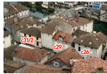
c29. Parcelle 38 rue de la Trémolière
