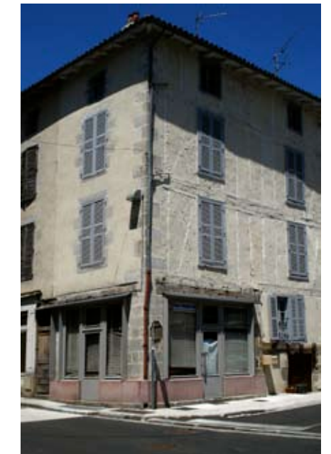
c26. Parcelle 21 rue de la Trémolière
