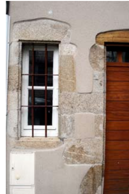
Le "retour" de l'enduit conduit souvent à une finition exagérément rustique, ou à des surépaisseurs gérées de manière parfois inopportune.
