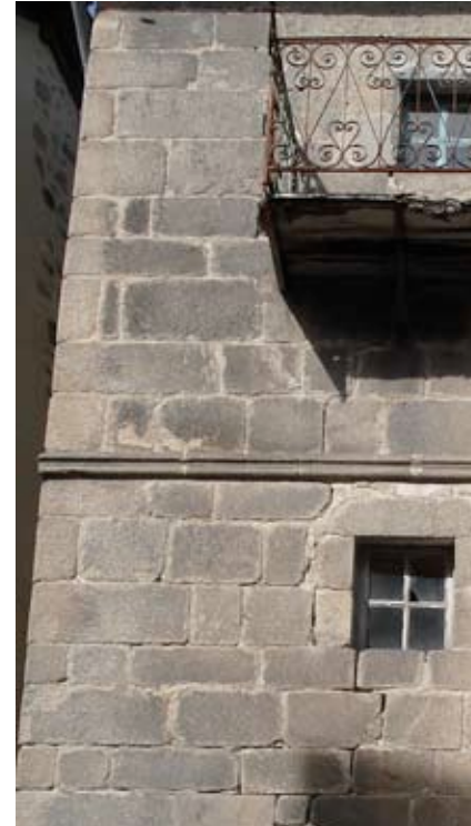
Façades d'origine médiévale en pierre appareillée (au début du XXe siècle, en 2008). On constate pour celle de gauche l'effacement des joints, qui se sont un peu érodés. Les lits présentent des largeurs différentes mais toujours régulières.
