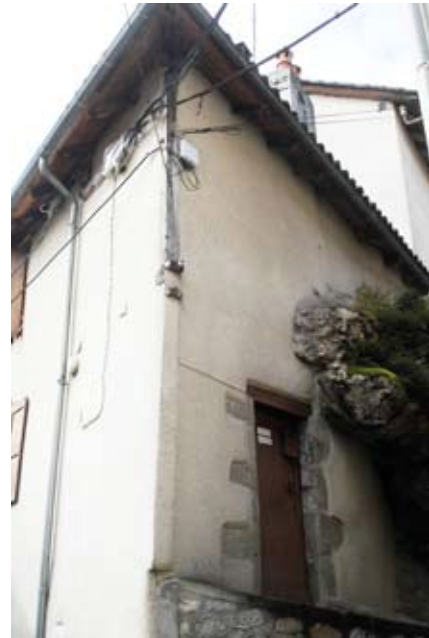
c11. Parcelle 54 rue du Fort
