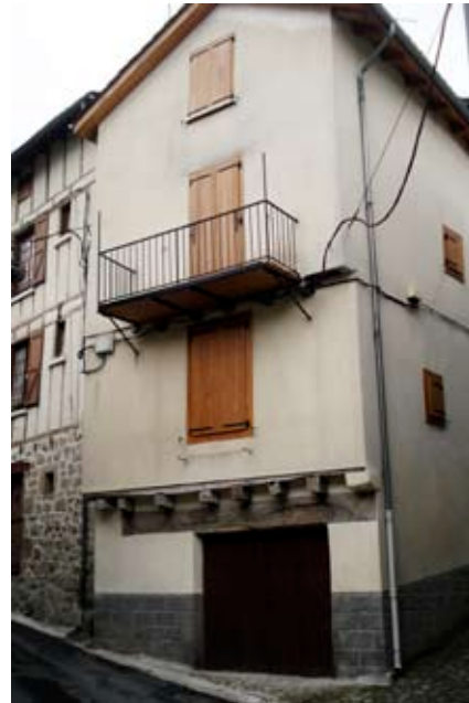
c78. Parcelle 116 rue du Nègrerieu Daté 1802
