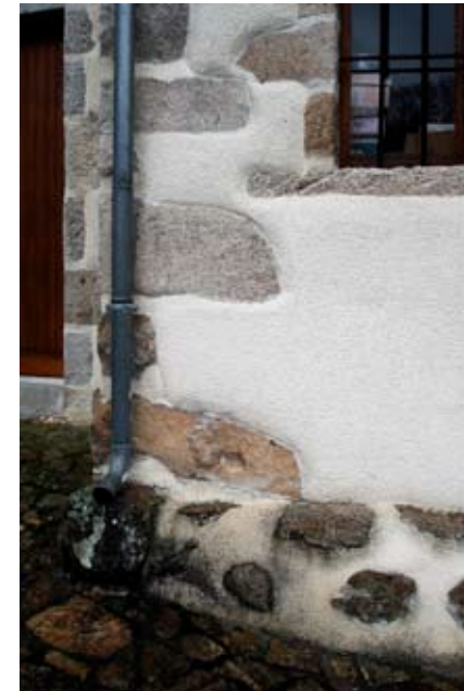
Le "retour" de l'enduit conduit souvent à une finition exagérément rustique, ou à des surépaisseurs gérées de manière parfois inopportune.
