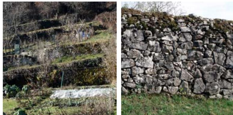
Les "petits" ouvrages en pierre (murs de jardins ou murets de soutènement des terres) doivent être restaurés à l'identique. Ces ouvrages sont parfois en partie liaisonnés au mortier.
