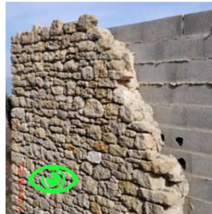
Revêtir une structure standard en parpaing de ciment ou de béton d'un parement de pierre est également une solution possible, car plus économique que la maçonnerie en masse homogène. (Construction de structures dans un site labellisé "plus beau village de France").
